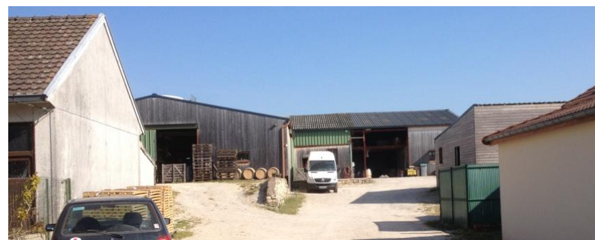
Tonnellerie, place de la mairie
