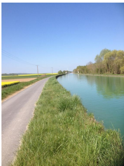
Vue sur le canal depuis le chemin latéral
